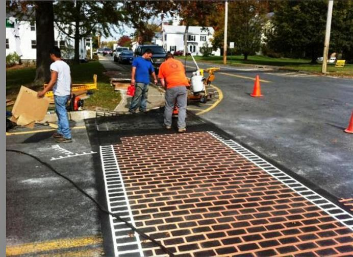
Составные части из термопластика помещают вместо оттиска и нагревают (метод тепловой сварки)
